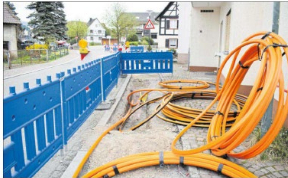
MODERNE TECHNIK: Viele Kilometer neue Rohre wurden bisher verlegt, um die Häuser mit Glasfaser und damit mit schnellem Internet zu versorgen. Foto: Gabriel
