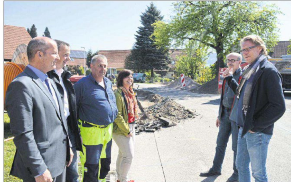
INFORMATION VOR ORT: Andreas Kienzler (rechts) von der Firma Peka Pflaster-, Erd- und Kabelbau gab einen Überblick über den Stand der Arbeiten in Hatzenweier. Foto: pr
