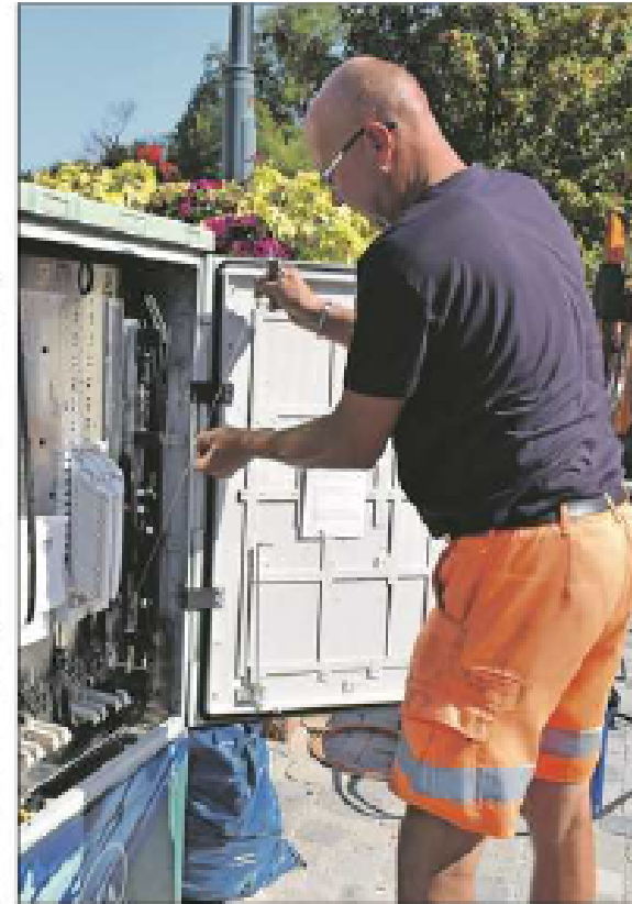
Von den Verteilerkästen werden die Glasfasern weitergeführt bis in die Häuser. Foto: Gabriel
