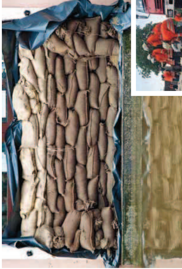
Schutzwälle aus Sandsäcken
