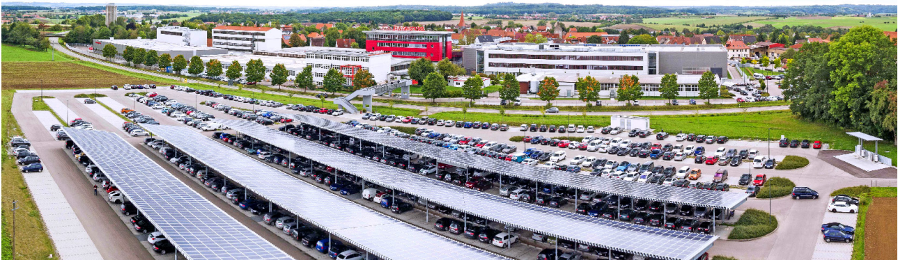
Abbildung 2: Mitarbeiterparkplatz im Landkreis Schwäbisch Hall mit Photovoltaik-Stellplatzüberdachung. Ausführung mit vier Stützen zwischen den Parkplätzen und Ausrichtung der Module in eine Richtung. Quelle: Bausch+Ströbel Maschinenfabrik
