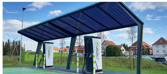
Abbildung 4: Solarer Mobilityhub für Parkplätze und E-Autos: E-Schnelladesäulen mit PV-Strom optional mit Informationsdisplay für Bürger, Paketstation, Getränkeautomat, LED-Beleuchtung, Sitzbank, W-LAN Hotspot, usw. – je nach Bedarf. Quelle: Zuweso GmbH – Für Nachhaltigkeit – www.station-i.de
