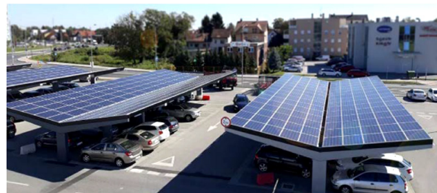
Abbildung 3: Photovoltaik-Stellplatzüberdachung: Überdachung von Stellplatzreihen mit Photovoltaikmodulen mit T-Profil-Tragwerksstruktur.
