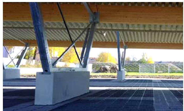
Abbildung 7: Stellplatzüberdachung mit Blechdach, Standardmodulen und großen Fundamenten.
