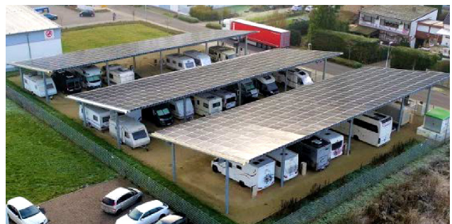
Abbildung 9: Photovoltaik-Stellplatzüberdachung für Wohnwägen und Wohnmobile.
