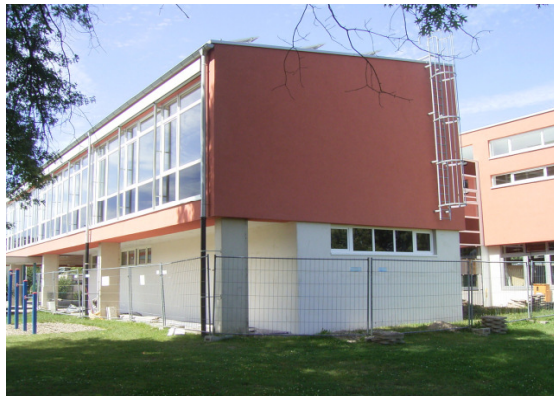
Sanierung Grundschule Unzhurst
