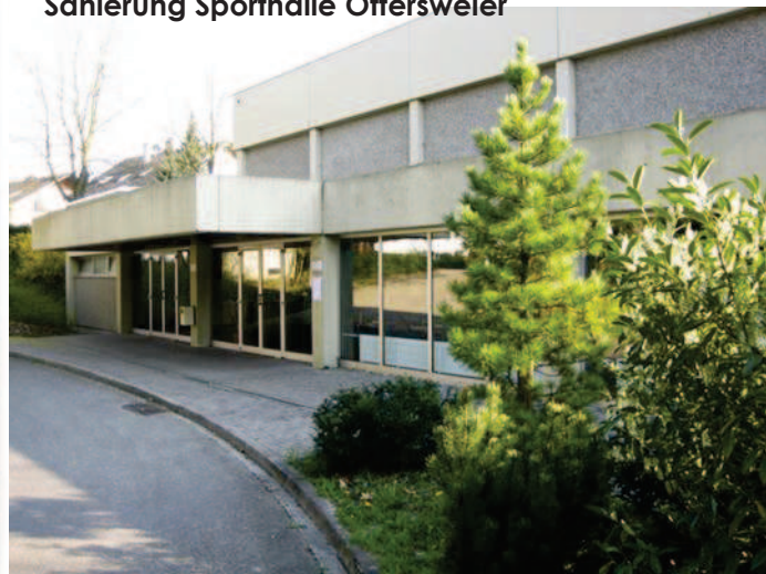
Sanierung Sporthalle Ottersweier
